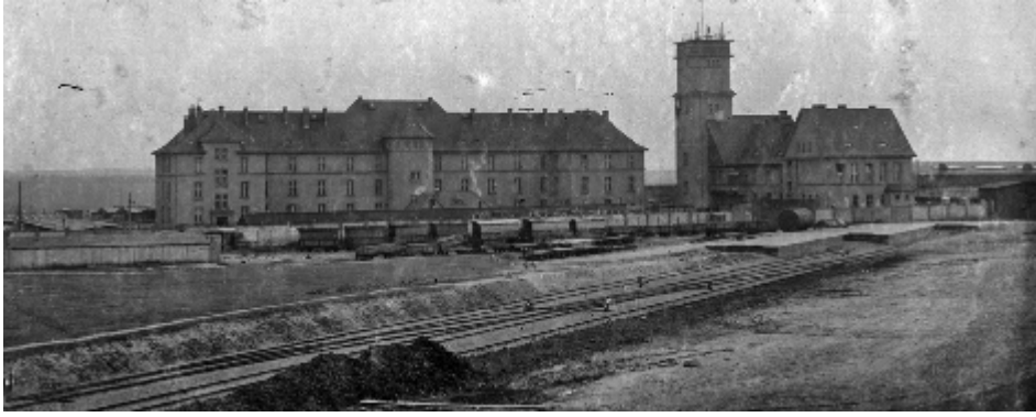
Die Gebäude der Flugstation in Ławica. Fot. von 1919 aus den Sammlungen der Digitalen Nationalen Bibliothek (CBN) „Polona“
